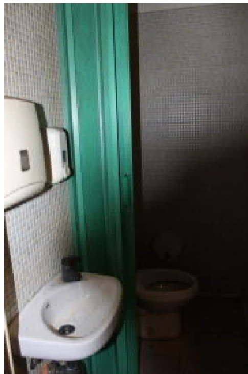
FOTO n°11: Vano 7 anti wc vano 7a w.c..
