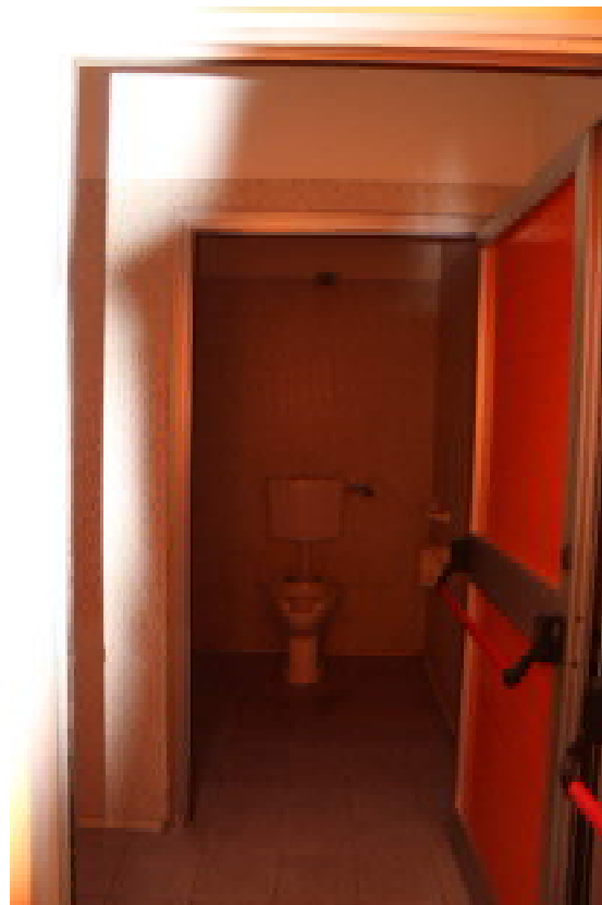
FOTO n°8: Vano 6 anti wc e Vano 6a, wc.
