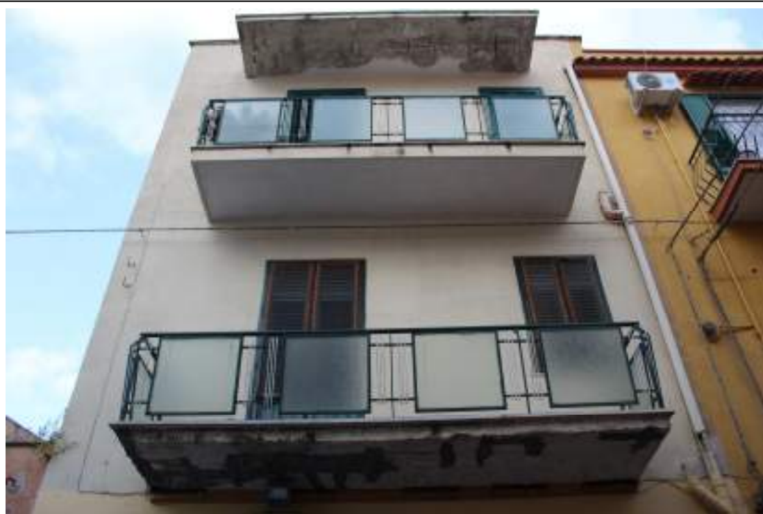
FOTO n°2: Edificio di cui fa parte l'u.i., ubicato in Cortile Chiavelli n°115..
