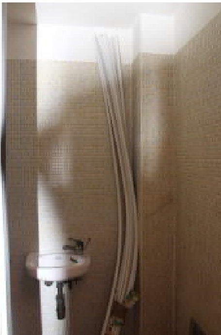
FOTO n°14: Vano 8, anti wc
