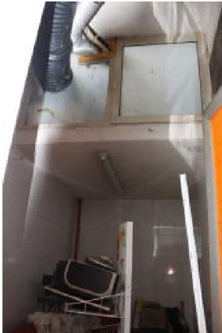
FOTO n°12: Vano 3, locale deposito.
