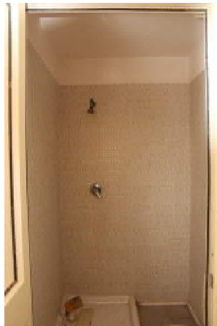
FOTO n°15: Vano 8a, w.c. doccia
