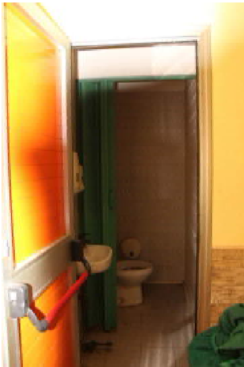
FOTO n°10: Vano 7, anti wc
